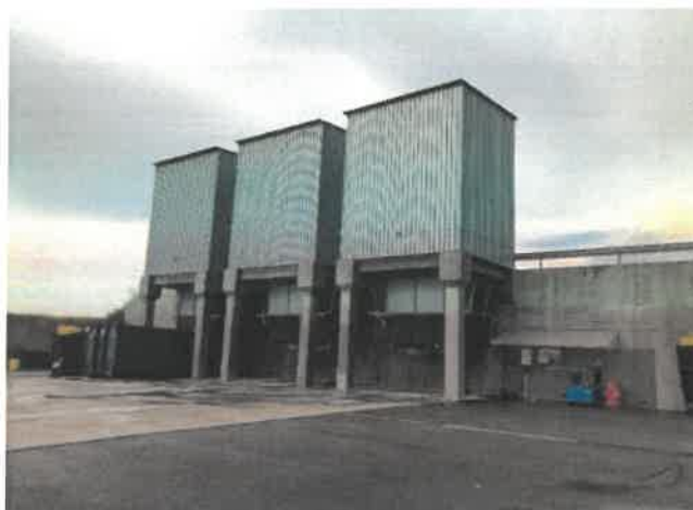
Figura nr. 18 –Stația de transfer Vânu Mare
